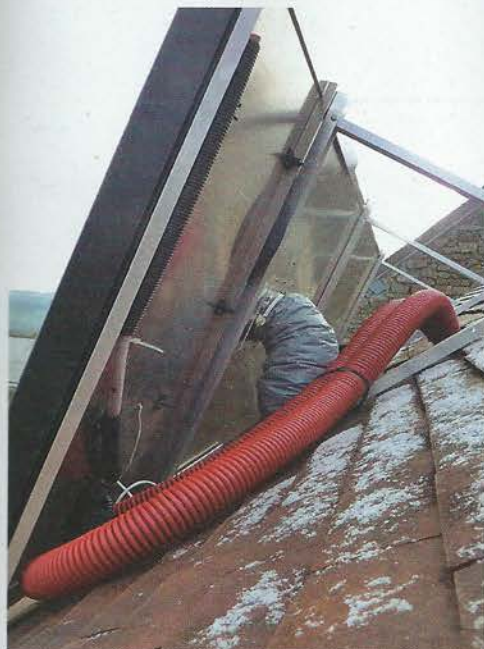
Ci-dessus : le capteur hybride pulse l'air chaud via le tuyau gris, les deux conduits rouges servant à la circulation de l'eau sanitaire.
